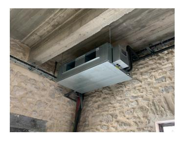
pour la configuration optimale des installations. Au total, la puissance installée est de 100 kW, répartie sur 4 gainables grandes puissances de 20 kW et 30 kW. À l'extérieur, le Groupe Verdier a installé six groupes mini DRV Heiwa Pro, tandis qu'à l'intérieur, une vingtaine d'unités ont été déployées.
