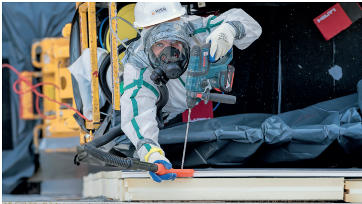
Cloche d'aspiration reliée à un aspirateur THE agréé amiante. Adaptée aux profils des parements M32 et M62, elle se fixe en toute simplicité pour effectuer les fixations.
